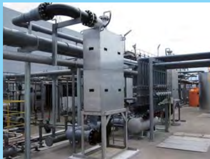
工場排水 難分解性成分易分解化 (オゾンガスUFB)
